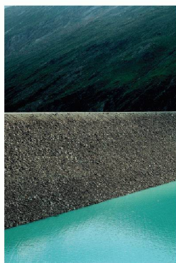
Der 2197 Meter über Meer gelegene, 1967 fertig gestellte Staudamm Mattmark im Kanton Wallis (siehe TEC21 36/2002) (Bild: KEYSTONE / Linda Herzog)
