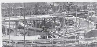
Abb. 13. EINSCHALUNG DER EISENBETON-SPIRALEN
