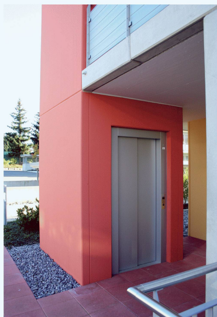
Fertiger Aussen-Liftschacht. Die feine Oberfläche des Betons kann leicht überstrichen werden.
