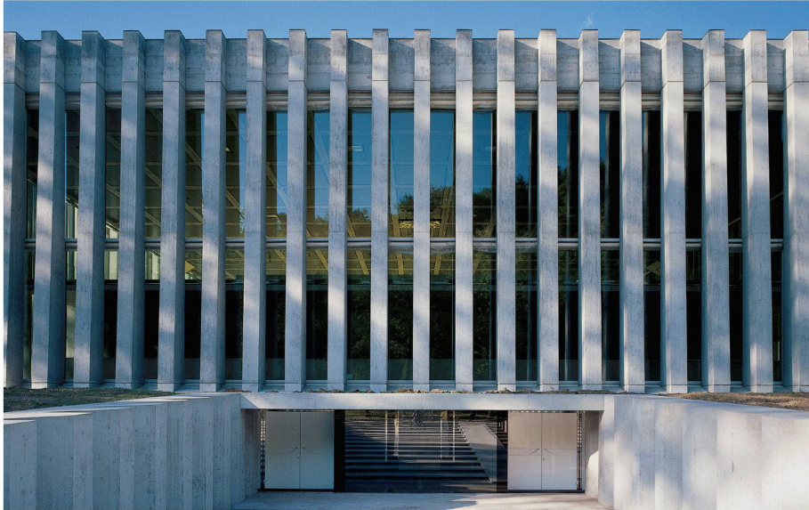
Livio Vacchinis Mehrzweckhalle in Losone (Bild: Gaston Wicky)
