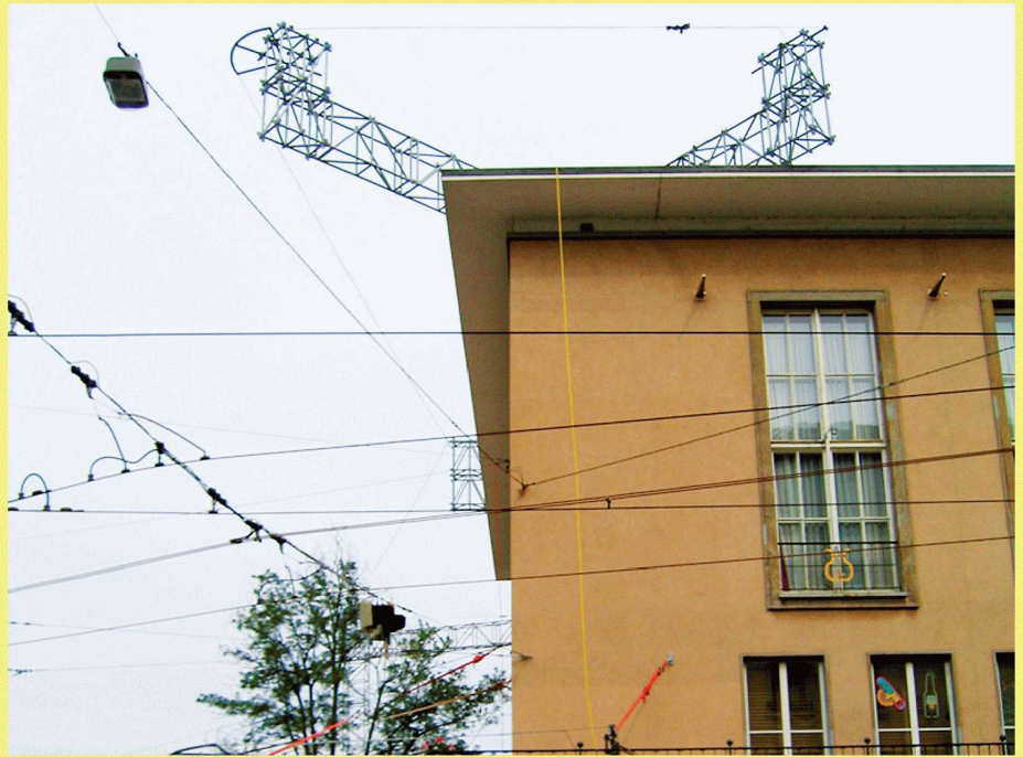
03 Bauprofil am heutigen Kopfbau des Stadtcasinos aus den 1930er-Jahren (Bild: Casino-Gesellschaft Basel)
