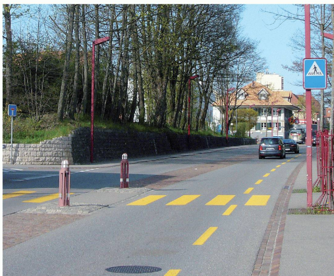
01 Der Abstand von einer Engstelle (z.B. Fussgängerschutzinsel) zur nächsten muss gross genug sein, um das Überholen von Velos durch einen LKW zu ermöglichen (Bilder: Autor)
