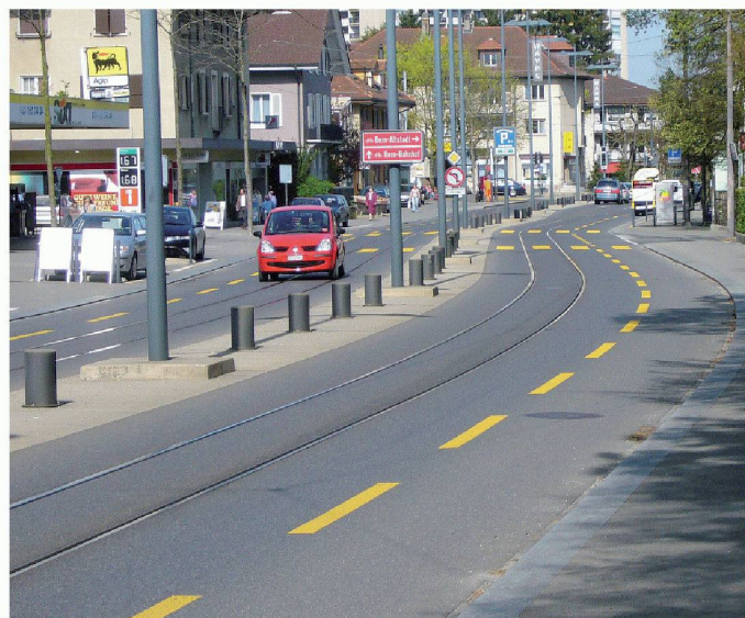
02 Die Fahrstreifenbreite beträgt jeweils 4.50 m, aufgeteilt in 3 m Fahrspur und 1.50 m Radstreifen. Die Mittelzone ermöglicht den Fussgängern ein flächiges Queren
