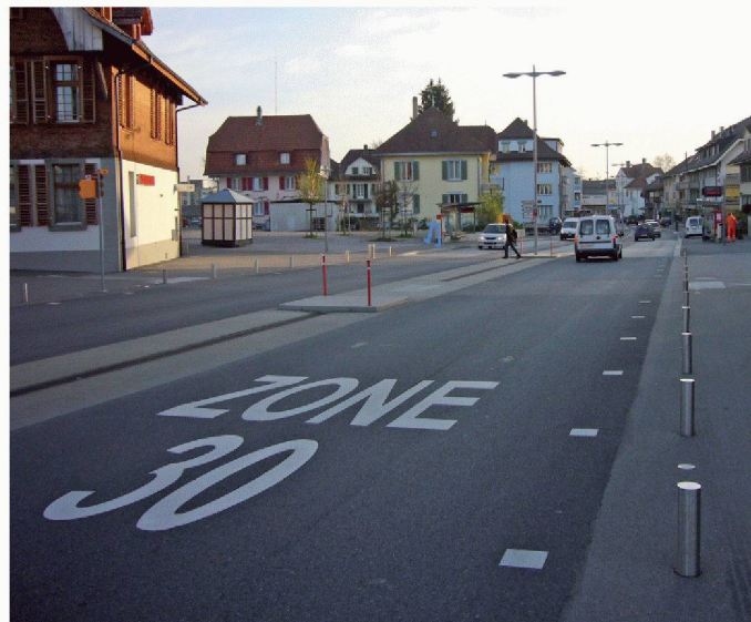
06 Die Durchfahrtsbreite von 4.20m ermöglicht bei Tempo 30 ein sicheres Überholen von Velo Fahrenden, auch wenn kein Radstreifen vorhanden ist
