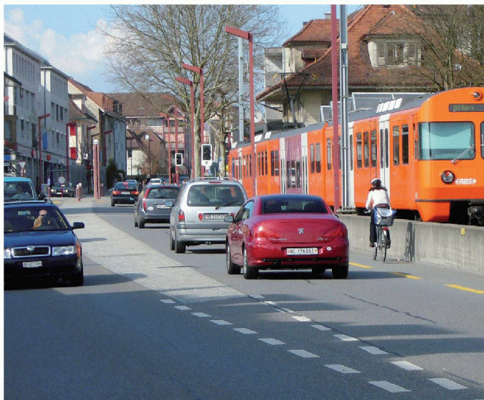
03 Ortsdurchfahrt mit einseitigem Radstreifen in der Steigung (Velokriechspur) und überfahrbarem Mehrzweckstreifen in der Mitte (Überholen Zweiräder, Linksabbiegen)
