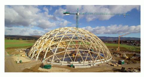
Der grösste Kuppelbau der Schweiz: «Saldome» der Schweizer Rheinsalinen (Aufnahme vom November 2004). Die Spannweite beträgt 93 m und die Höhe 31 m. Das bogenförmige Tragwerk ist aus verleimtem Holz konstruiert. Die Kuppelform entsteht durch ein Netzwerk mit 163 Knotenpunkten. Die Knoten wiederum sind mit 402 zwischen 5 m und 11 m langen Trägerbalken untereinander verbunden (Bild: Beat Zimmermann / Lignum)
