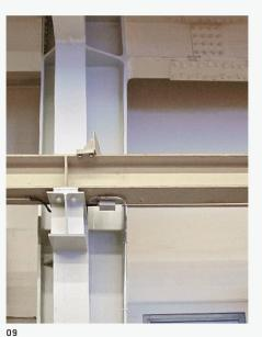
05-09 Im Erdgeschoss des bestehenden Industriegebäudes musste die Stahlrahmenstruktur hinsichtlich des Feuerwiderstands neu beurteilt werden. Im Grundriss und im Schnitt sind der beurteilte Raum und die darin betroffenen Stahlträger markiert (Bilder: Kaufmann, van der Meer + Partner AG, bzw. Autoren) 10 Die für den Brandraum erstellte Naturbrandkurve zeigt, dass der Temperaturverlauf deutlich von der ISO-Normbrandkurve abweicht 11-13 Simulationen haben gezeigt, dass die tragenden
