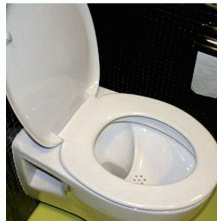
Im NoMix-WC wird im vorderen Teil der Schüssel der Urin abgetrennt (Bild: Eawag)
