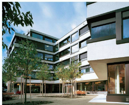
05+06 Neubau Altersresidenz Spingarten in Altstetten, Zürich. Die selbsttragende Fassade besteht aus fugenlos vorgespannten Brüstungselementen (Miller & Maranta Architekten, Basel; WGG Schnetzer Puskas Ingenieure AG, Basel)
