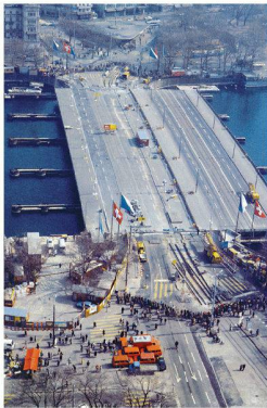
Verschiebung beim Ersatz der Quaibrücke in Zürich 1984 (Schweizer Ingenieur+Architekt Nr. 10, 1985)
