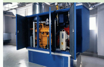
Gasmotor-Blockheizkraftwerk (BHKW)
