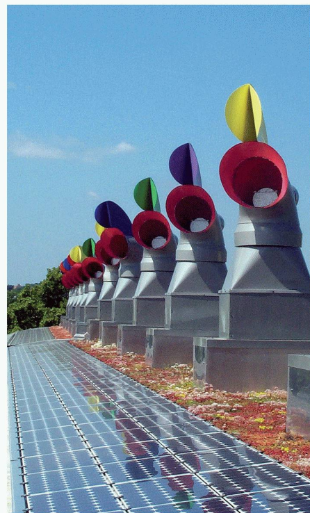
Die farbigen Kamine auf den Dächern enthalten windgetriebene Ventilatoren mit Wärmerückgewinnung (Bilder: Bill Dunster Architects)
