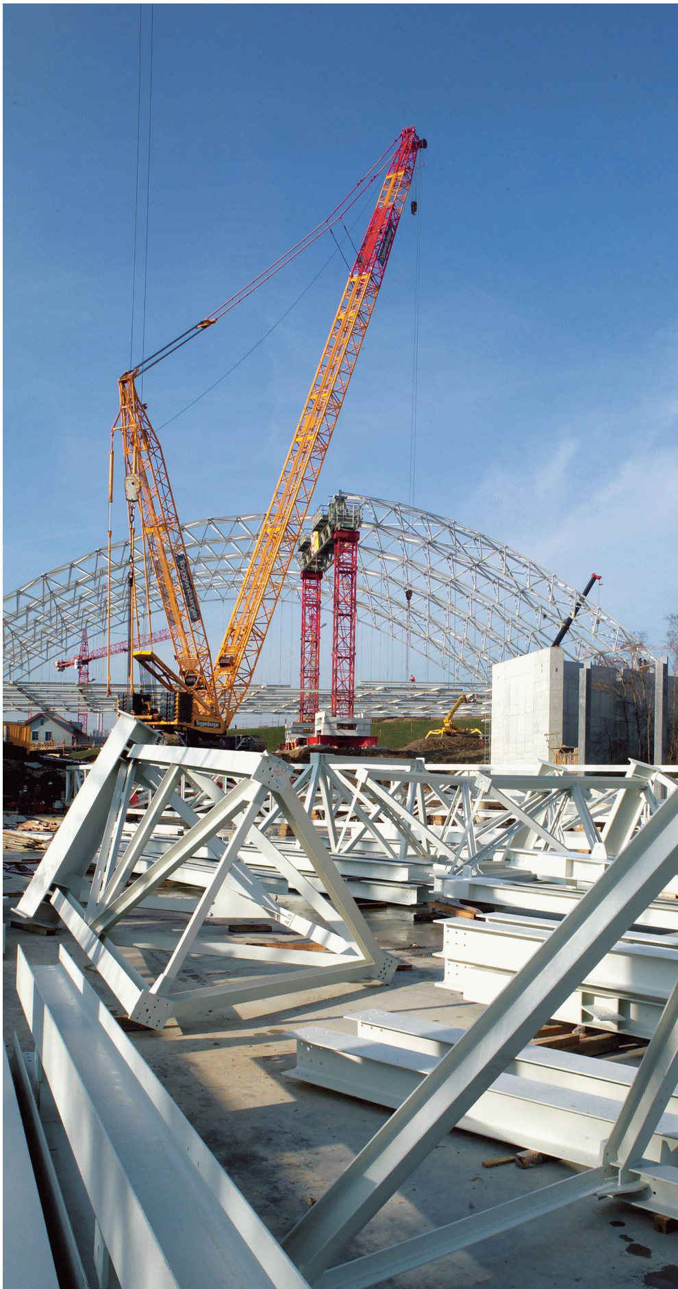
05 Die 6 m langen und 2.5 m hohen Fachwerkelemente vor dem Zusammenbau (Bild: Christian Schwager)
