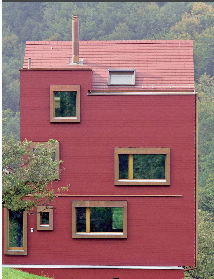
Architekt: Hubert Bischoff , Wolfhalden Dach: DACHSCHIEFER Fassade: FASSADENSCHIEFER
