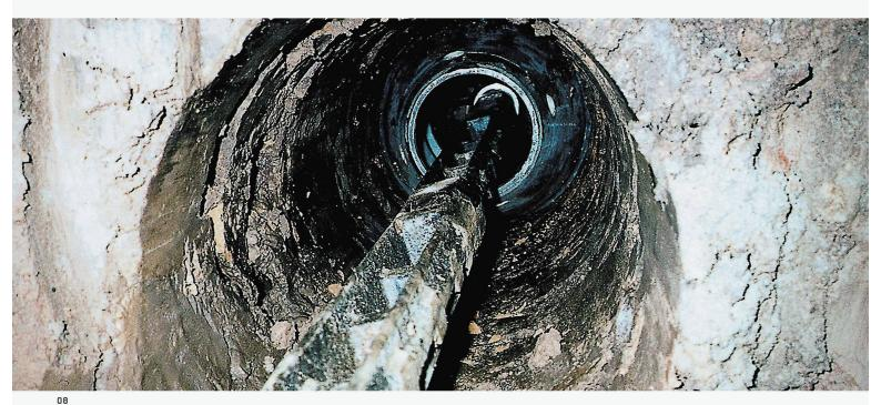
04 Startvorbereitung in der Zielgrube. Der grösste bisher geborstene Kanal hatte einen Durchmesser von 800 mm 05 Blick in die Maschinengrube 06 Mit dem TIP-Verfahren wird eine Einbaugeschwindigkeit von 10–15 m/h erreicht 07 Bei grabenlosen Verfahren wird das Neurohr in der Trasse des bestehenden Rohres geführt 08 Statisches Berstlining-Verfahren, Innenansicht eines geborstenen Rohres (Bilder: karo-san)
