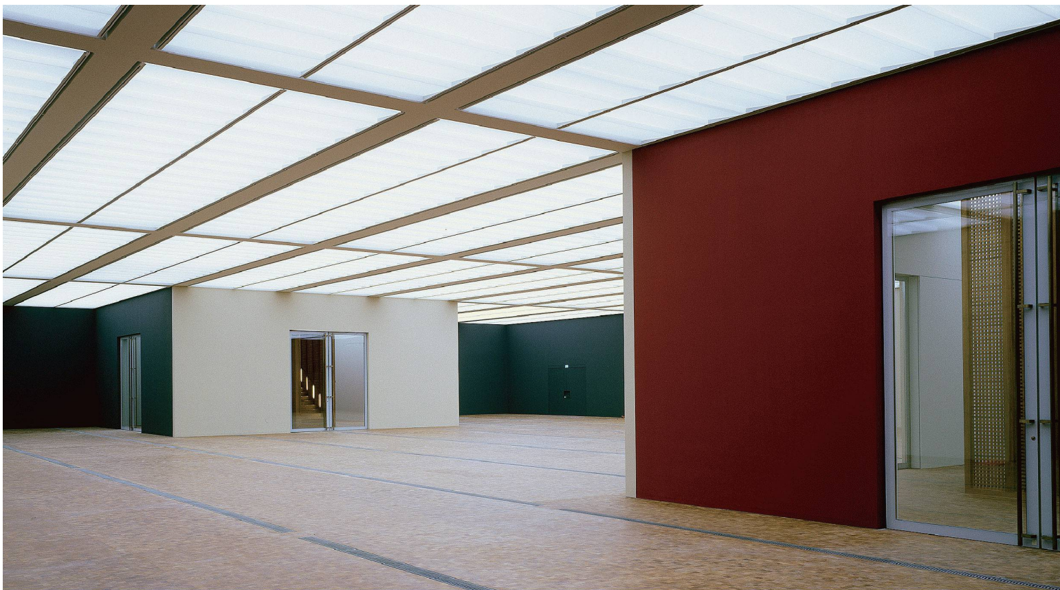
08 Der grosse Ausstellungssaal im 2. UG mit den beiden Raumvierten aus tragenden Wandscheiben (Bilder: Heinrich Helfenstein)
