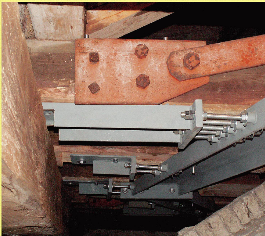
13 Verankerungen eines Stahlrings in den Bundbalken. Das Bild entspricht der Position unten rechts in Bild 10
