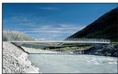
Tre ponti sul nuovo fiume Flaz Andrea Pedrazzini, Ingegnere Ingegneri Pedrazzini sagl Via delle Scuole 1 6900 Lugano
