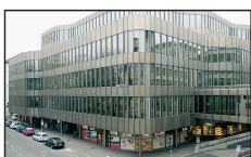
UBS AG Zürich, Sanierung Bärengasse 16 Andres Carosio Architekten Luzern
