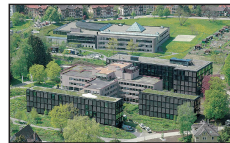
Umbau und Erweiterung Helvetia Patria Versicherungen St. Gallen
