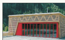
Werkhof in Safien Albertin: Zoanni: Architekten Haldenstein
