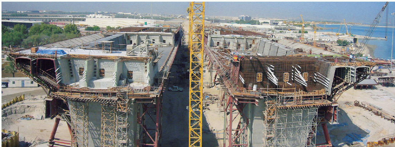
Shaikh Zayed Bridge von Zaha Hadid: Der Oberbau der Brücke wird in zwei getrennten Kastenträgern erstellt. Die Fahrbahn, mit vier Spuren pro Richtung, wird mit Hängkabeln an den Stahlbögen aufgehängt (Bilder: Archirodon)
