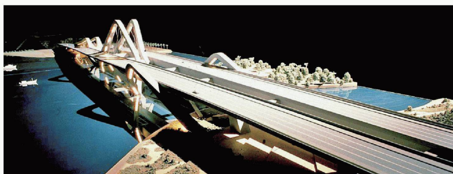
Die Gesamtlänge der Brücke beträgt 842.355 m, die Höhe 5.50 m, und sie weist mit beiden Fahrbahnen eine gesamte Breite von zweimal 23.7 m auf
