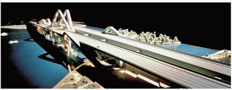
Die Gesamtlänge der Brücke beträgt  $842.355\,\mathrm{m}$ , die Höhe  $5.50\,\mathrm{m}$ , und sie weist mit beiden Fahrbahnen eine gesamte Breite von zweimal  $23.7\,\mathrm{m}$  auf
