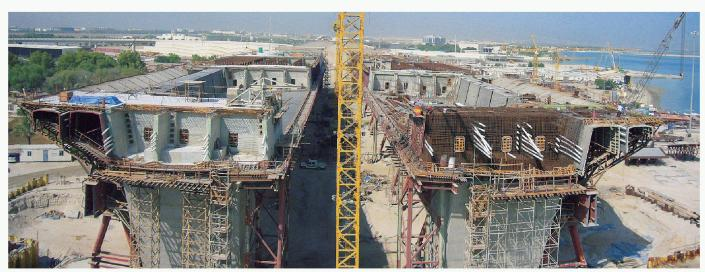
Shaikh Zayed Bridge von Zaha Hadid: Der Oberbau der Brücke wird in zwei getrennten Kastenträgern erstellt. Die Fahrbahn, mit vier Spuren pro Richtung, wird mit Hängekabeln an den Stahlbögen aufgehängt (Bilder: Archirodon)
