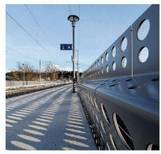
01+02 In fünf Monaten Bauzeit entstand die Haltestelle «Luzern Verkehrshaus». Als Gestaltungselement wurden grossformatige, perforierte und gefaltete Stahlplatten eingesetzt. Sie dienen als Geländer, als Stehbank für die Fahrgäste und als Verkleidung des Restraumes (Bilder: Lucas Peters)
