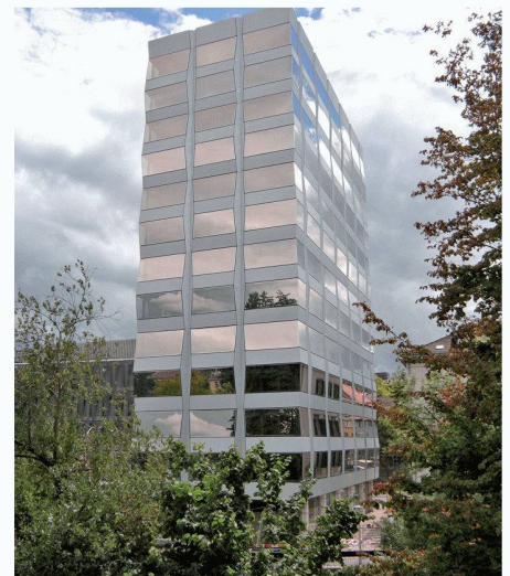
Das neu umgebaute SIA-Haus (Bild: D. Loehrmann)
