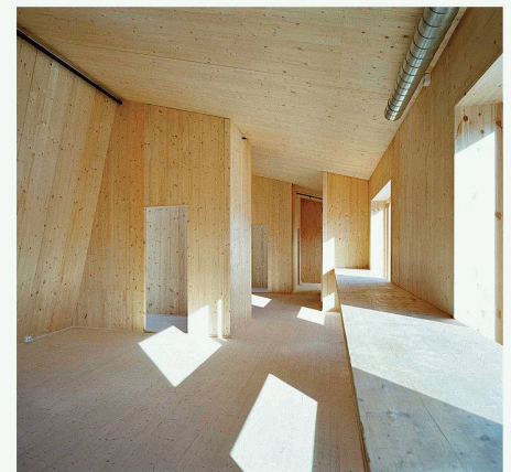
03+04 Svartlamoen-Haus in Trondheim aus Massivholzplatten. Es besteht aus einem fünfstöckigen Wohnhaus und einem kleineren Nebengebäude. Die vornehmlich jüngeren BewohnerInnen verfügen privat nur über kleine Appartements oder Schlafzimmer, der Grossteil der Wohnfläche wird gemeinschaftlich genutzt. Architektur: Brendeland & Kristoffersen, Trondheim, 2005 (Bilder: Johan Fowein)
