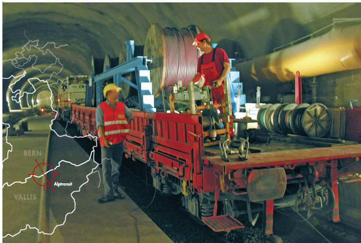
Projekt : Verkabelung des Lötschbergtunnels, des längsten Eisenbahntunnels Kontinentaleuropas [850 km Energiekabel und 700 km Fernmeldekabel]
