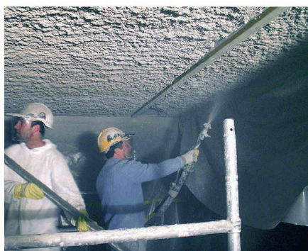
Verarbeitung von Sika-Cafco® 300 im Nassspritzverfahren.
