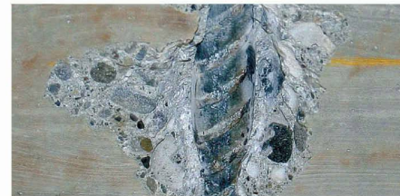
Sondieröffnung an der Deckenuntersicht. Kaum Korrosion trotz geringer Betonüberdeckung.
