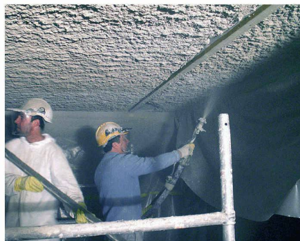
Verarbeitung von Sika-Cafco® 300 im Nassspritzverfahren.
