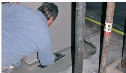
Spachtelung der Stützenfüsse mit Sikagard®-720 EpoCem®
