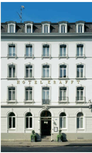
Hotel «Krafft», Fassade Rheingasse (Bild: Dirk Altenkirch)
