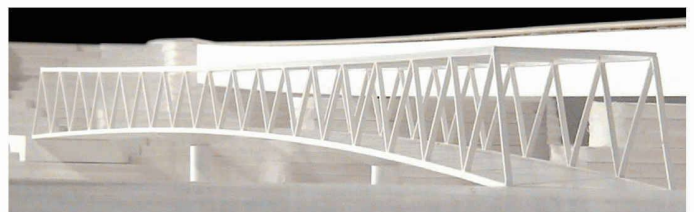
3-feldrige Fachwerkkonstruktion aus Stahl (4. Rang, Walt + Calmarini)
