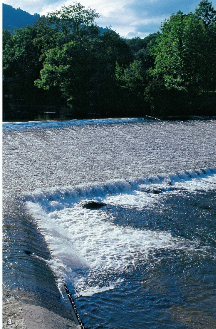
Befestigte Flusssohle. Ähnlich, aber mit weniger Gefälle soll der Fluss auch bei niedrigem Wasserstand über das Hindernis schäumen und sprudeln und als Wasserspiel die Betrachter anziehen (Bild: LB/Red.)
