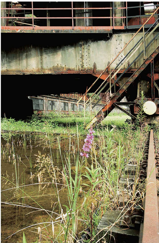
Industriebrache: Gelände der ehemaligen Kokerei Hansa in Dortmund (Bild: Klaus-Peter Schneider)
