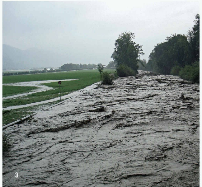
Hochwasserentlastung mit Streichwehrkante vor Buochs (Bilder: Tiefbauamt Nidwalden)
