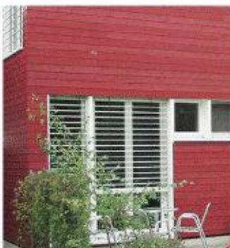
Umweltgesetze, Luftreinhalteverordnung und Chemikalienrecht zwingen Hersteller zu einer immer stärkeren Reduktion von Lösemitteln in Anstrichstoffen. Diotrol-Aqua-Naturöl-Lasur erfüllt diese Anforderungen. Es ist gelungen, eine wasserverdünnbare, lösemittelfreie Lasur auf Basis verschiedener nachwachsender Naturöle zu formulieren. Nach
