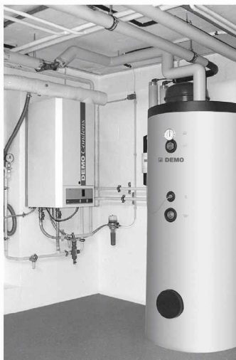
Unter den Öl-Brennwertkesseln gibt es auch Wandgeräte.
