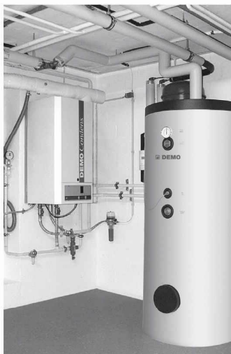
Unter den Öl-Brennwertkesseln gibt es auch Wandgeräte.
