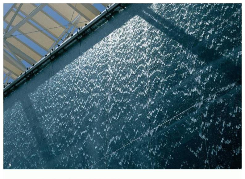
ständig reflektiert und im Winter die flach eintreffende Strahlung eindringen lässt (Bild 5). Der g-Wert schwankt folglich zwischen 48 und 17 %, der U-Wert beträgt  $0.48~\mathrm{W/m^2K}$ .
