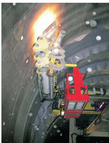
Maschinelles Verkleben der Dichtungsfolien im Isisbergtunnel ZH (Bild: Autor)
