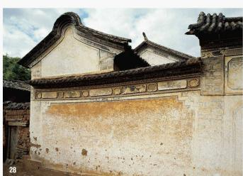
indem sie die Fundamente sanierten und vergrösserten, die Fugen zwischen den Adobeblöcken auffüllten, das Dach reparierten und das Vordach, das sich früher auf der der Stadt zugewandten Seite befand, ergänzten. Auf weitere Eingriffe verzichteten sie und beliessen das Infinito der Finitura (Bild 20).
