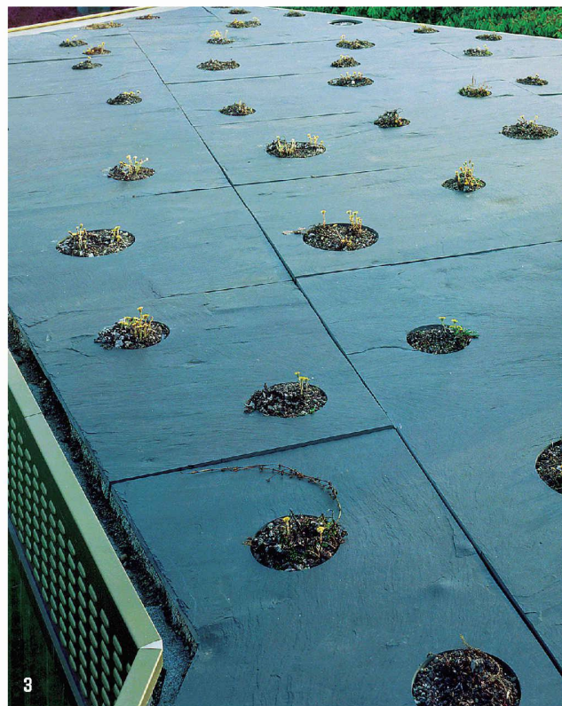
3 Das begrünzte Schieferdach (Bild: Sollberger & Bögli)
