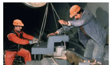
Die vonRoll Stufenabdeckung aus Duktulguss ist robust, dicht und klapperfrei.
