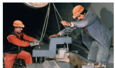
Die vonRoll Stufenabdeckung aus Duktulguss ist robust, dicht und klapperfrei.
