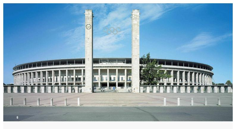
6 Das Olympiastadion nach der Sanierung. Das neue Dach überragt das Stadion nur leicht, die durchdachte Konstruktion minimiert den Dachaussenrand auf wenige Zentimeter (Bild: Heiner Leiska)
