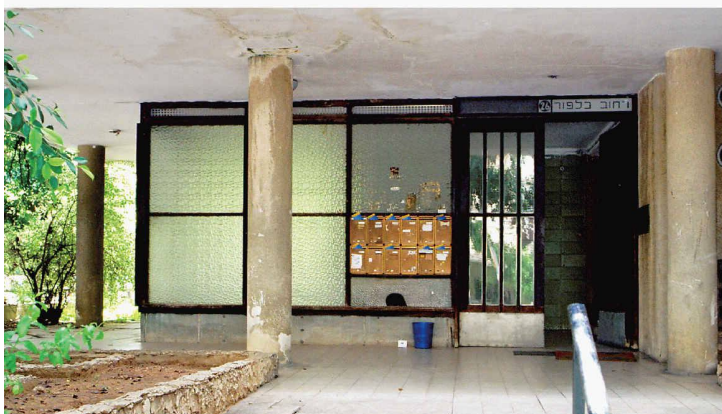
Links: 24–26 Balfour Street, von Shlomo Flato, 1935. Das dreigeschossige Haus steht auf einem weitgehend offenen Erdgeschossgrundriss mit runden Betonstützen, gemäss den Gestaltungsprinzipien Le Corbusiers (Bild: Ch. von Büren)
