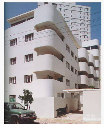
Links: 24–26 Balfour Street, von Shlomo Flato, 1935. Das dreigeschossige Haus steht auf einem weitgehend offenen Erdgeschossgrundriss mit runden Betonstützen, gemäss den Gestaltungsprinzipien Le Corbusiers (Bild: Ch. von Büren)
