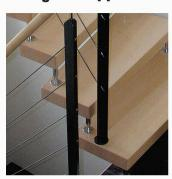
Die frei tragende Treppenkonstruktion in Kombination mit dem Drahtseil-Geländer wirkt besonders leicht im Raum. Das Geländersystem aus T-Pfosten ist schwarz lackiert, die Stufen aus massivem Ahornholz gefertigt. Kenngott-Treppen sind auch in vielen anderen Materialkombinationen erhältlich.
