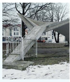
Buswartehäuschen in Binz, 1967. Versuchsbau von  $7 \times 7$  m für die 1968 in Rostock Lütten-Klein gebaute Mehrzweckhalle
