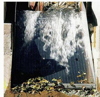
Der Coanda-Rechen ist ein Schutzfilter für Rohrleitungen und Wasserkraftanlagen. Er wird aus rostfreien Profilstäben aus Stahl hergestellt und nach einem Grob-rechen in die Wehranlage eingebaut. Er hält mindestens 90 % des Geschiebes und des Schwemm-guts mit einem Korndurchmesser grösser als 0.5 mm von der Fassung fern. Der Coanda erfordert keinen Antrieb und ist selbsteinigend. Dank dem Abscher-Effekt der Pro-filstäbe fliesst das Wasser mit einer Kapazität von 1121/s pro Meter durch den Rechen.
