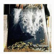
Der Coanda-Rechen ist Schutzfilter für Rohrleitungen und Wasserkraftanlagen. Er wird aus rostfreien Profilstäben aus Stahl hergestellt und nach einem Grobrechen in die Wehranlage eingebaut. Er hält mindestens 90 % des Geschiebes und des Schwemmguts mit einem Korndurchmesser grösser als 0.5 mm von der Fassung fern. Der Coanda erfordert keinen Antrieb und ist selbstreinigend. Dank dem Abscher-Effekt der Profilstäbe fliesst das Wasser mit einer Kapazität von 1121/s pro Meter durch den Rechen.
