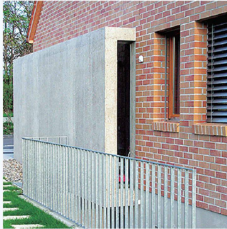
NW-Wand der 2003 in Sichtbeton aus Mischabbruchgranulat erstellten Garage eines Einfamilienhauses (Bild: Werner Studer)
