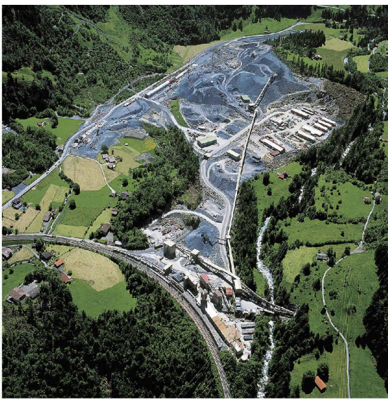
Luftbild der Neat-Baustelle Mitholz. Oben links der Lawinenschutz-Strassentunnel während der Bauzeit, vor der Überdeckung (Bild: BLS Alptransit)
