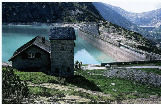
Die Stauwehrranlage des Gelmersees bei Guttannen (Bauzeit 1925–1929) war der erste Stausee für die Wasserkraftwerke im Haslital und wird bei ISIS detailliert gezeigt (Bild: Hans-Peter Bärtschi)
