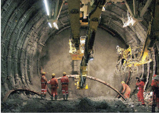
Stahleinbau im Gotthardtunnel. Ein Vergaberekurs wird die Fertigstellung voraussichtlich verzögern (Bild: ATG)
