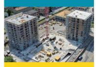
Auch die Wohnsiedlung Werdwies in Zürich-Grünau ist mit Recycling-Beton erster Güte gebaut. Der RC-Euro Beton (C30/37 XC4) wird für Bauteile eingesetzt, welche wechselnd nass und trocken sind. Hergestellt wird er nach Eigenschaften auf der Grundlage der Norm SN EN 206-2000:1 und wird als Kran- oder Pumpbeton geliefert. Die Gesteinskörnungen bestehen aus gebrochenem Betongranulat und aus rezyklierten Gesteinskörnungen aus der Bodenwaschanlage ESAR. Der Recyclinganteil beträgt über 90%!
