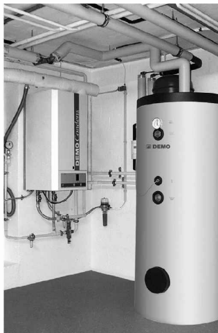
Unter den Öl-Brennwertkesseln gibt es auch Wandgeräte.
