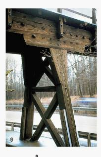
Diese 1938 erstellte (und inzwischen abgerissene) Holzbrücke bei Pforzheim erreichte durch einen konstruktiven Holzschutz (Asphaltbelag) eine lange Lebensdauer bei gleichzeitig geringem Unterhalt
