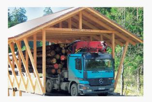
Die erste deutsche Schwerlastbrücke (60 t) in Holzbauweise führt über den niedersächsischen Brunnenbach. Der Bauherr erwartet von der Brücke eine Nutzungsdauer von 100 Jahren
