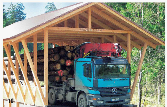
Die erste deutsche Schwerlastbrücke (60 t) in Holzbauweise führt über den niedersächsischen Brunnenbach. Der Bauherr erwartet von der Brücke eine Nutzungsdauer von 100 Jahren
