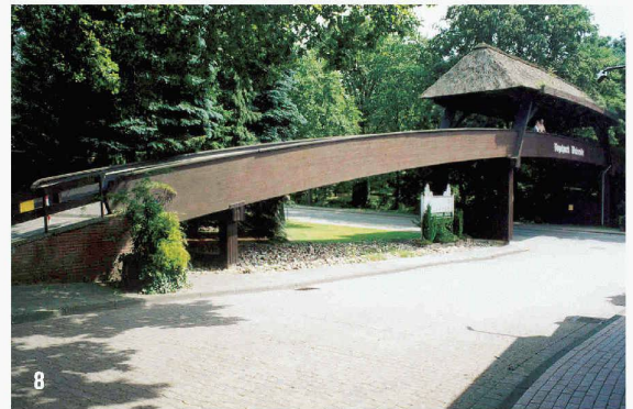
Regelmässige Neuanstriche ermöglichen der ungeschützten Fuss- und Radwegbrücke in Walsrode aus dem Jahre 1972 das Erreichen ihrer theoretischen Nutzungsdauer von 40 Jahren
