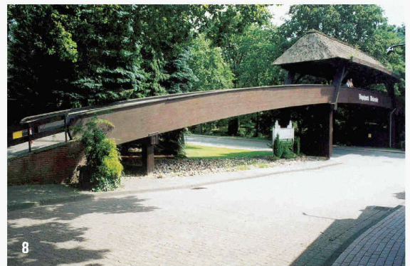
8 Regelmässige Neuanstriche ermöglichen der ungeschützten Fuss- und Radwegbrücke in Walsrode aus dem Jahre 1972 das Erreichen ihrer theoretischen Nutzungsdauer von 40 Jahren
