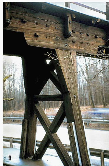
9 Diese 1938 erstellte (und inzwischen abgerissene) Holzbrücke bei Pforzheim erreichte durch einen konstruktiven Holzschutz (Asphaltbelag) eine lange Lebensdauer bei gleichzeitig geringem Unterhalt
