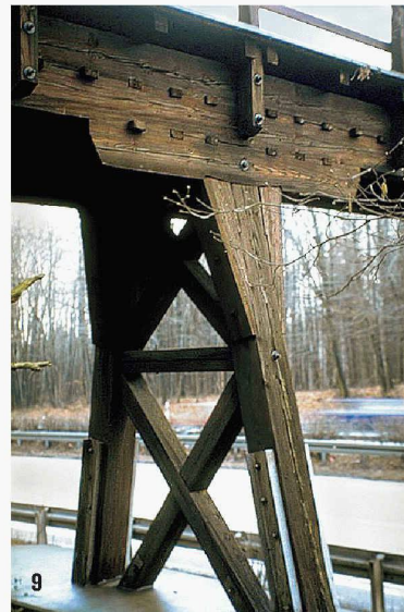
Diese 1938 erstellte (und inzwischen abgerissene) Holzbrücke bei Pforzheim erreichte durch einen konstruktiven Holzschutz (Asphaltbelag) eine lange Lebensdauer bei gleichzeitig geringem Unterhalt
