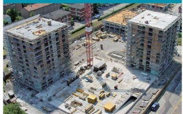
Auch die Wohnsiedlung Werdwies in Zürich-Grünau ist mit Recycling-Beton erster Güte gebaut. Der RC-Euro Beton (C30/37 XC4) wird für Bauteile eingesetzt, welche wechselnd nass und trocken sind. Hergestellt wird er nach Eigenschaften auf der Grundlage der Norm SN EN 206-2000:1 und wird als Kran- oder Pumpbeton geliefert. Die Gesteinskörnungen bestehen aus gebrochenem Betongranulat und aus rezyklierten Gesteinskörnungen aus der Bodenwaschanlage ESAR. Der Recyclinganteil beträgt über 90%!
