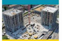
Auch die Wohnsiedlung Werdwies in Zürich-Grünau ist mit Recycling-Beton erster Güte gebaut. Der RC-Euro Beton (C30/37 XC4) wird für Bauteile eingesetzt, welche wechselnd nass und trocken sind. Hergestellt wird er nach Eigenschaften auf der Grundlage der Norm SN EN 206-2000:1 und wird als Kran- oder Pumpbeton geliefert. Die Gesteinskörnungen bestehen aus gebrochenem Betongranulat und aus rezyklierten Gesteinskörnungen aus der Bodenwaschanlage ESAR. Der Recyclinganteil beträgt über 90 %!
